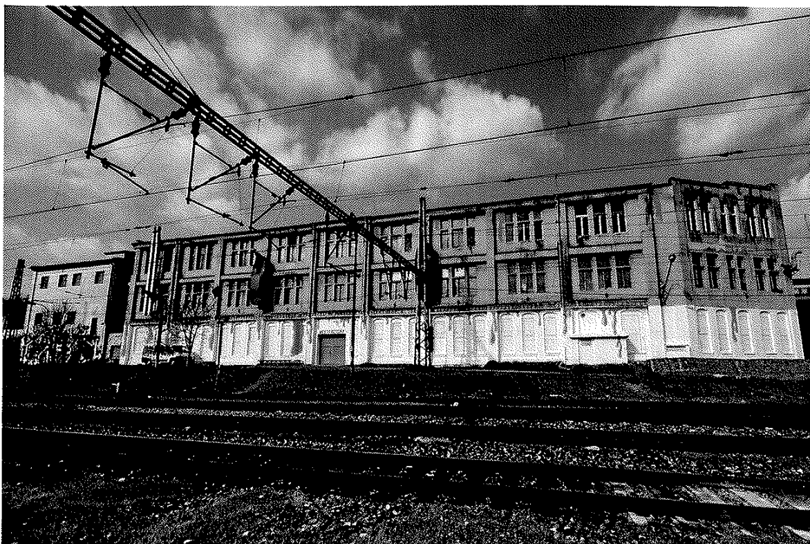
Budova MeetFactory – mezinárodního centra pro současné umění
